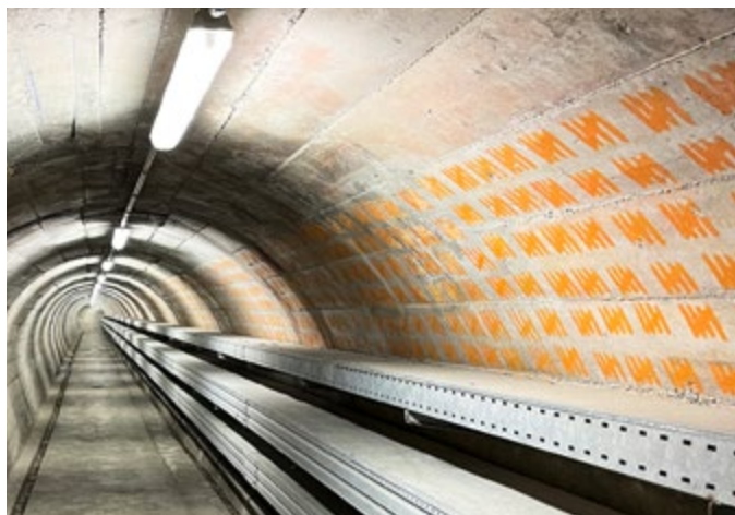
20 000 traits peints sur la longue paroi du tunnel montrent pour combien de personnes l'abri a été prévu. Photo Stéphane Herzog
