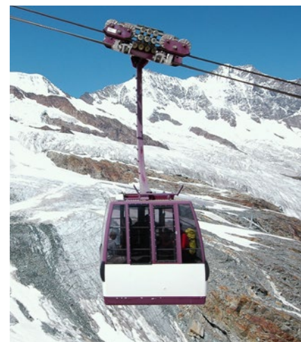
Ce téléphérique est également synonyme d'innovation: le premier téléphérique au monde sur trois câbles dessert la montagne depuis 1991 à Saas Fee. Photo Martin Arnold
