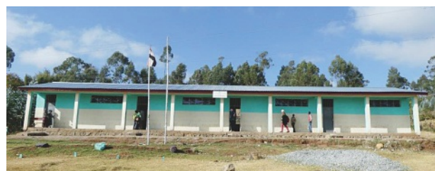
Fertiges Schulhaus 2016 mit 4 Klassenräumen zu 60 Plätzen
